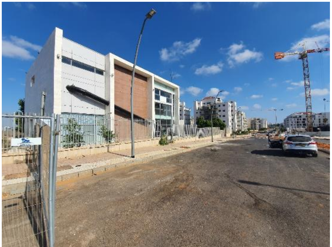
איור 81 - מסוף שכונת נווה זמר - מבט מקצה השכונה. ניתן לראות את צנור המערכת הפנאומטית עולה מהאדמה לתוך המסוף. המסוף קרוב למבני מגורים ובעתיד לבית ספר
