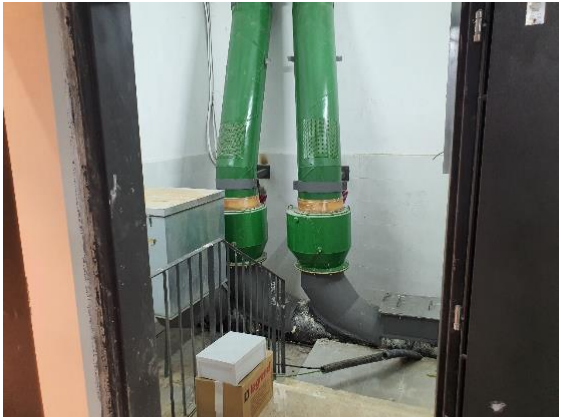
איור 86- חדר מגופים בתחתית המבנה. הצינורות הירוקים מחוברים לשטים אנכיים שבאים מהקומות ובהם נאגרת האשפה. מתחת לכל צינור יש מגוף המחובר לצנרת האופקית שמתחברת לצנרת הציבורית. הקופסא מצד שמאל הוא מגוף כניסת אוויר עם משתיק קול.
