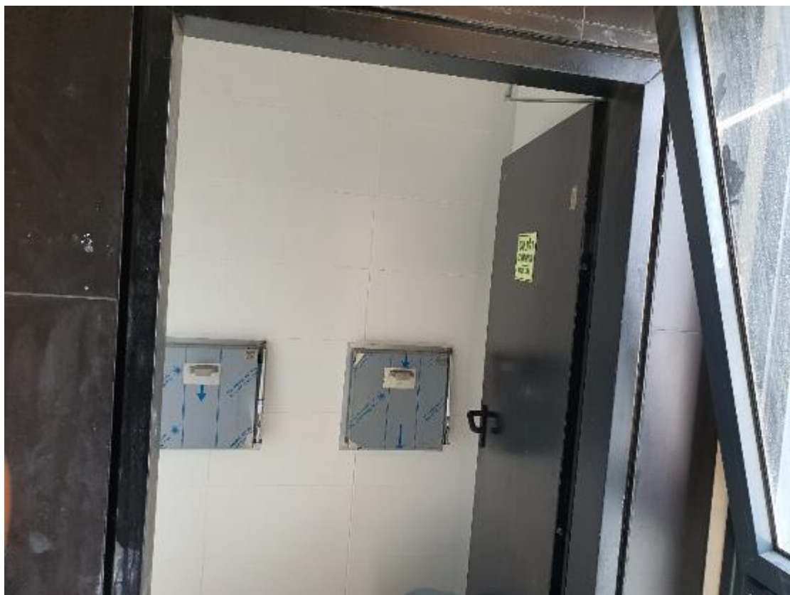
איור 83 - חדר אשפה קומתי. הדייר נפגש רק עם החדר הזה שבו הוא משליך את האשפה לאחת משתי הדלתות – כל דלת לזרם אשפה שונה. מקור: חיים אוסטר
